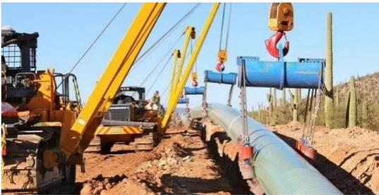
**Bajada de la tubería a la zanja.** A través de diversos tractores pluma conjuntamente se bajará la tubería, considerando el recubrimiento de la tubería inspeccionado mediante el uso de un detector de defectos en el recubrimiento. En caso de ser necesario se realizarán las reparaciones pertinentes.
