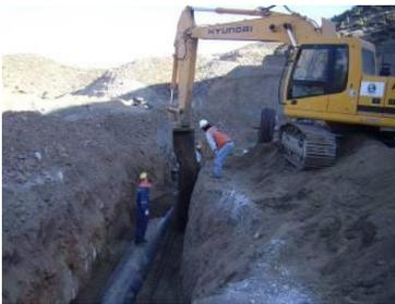
Cabe mencionar, que las zonas rocosas se excavarán con una profundidad que permita el acolchado por debajo de la tubería. Así, logrando que la tubería se haya doblado antes del zanjeo, podrá requerirse mayor exigencia, incluyendo el uso de estacas cortadas para asegurar que la tubería encaje en la zanja. Se contempla que el gasoducto se encontrara a una **profundidad promedio de 1.8 metros**. La inspección de la obra controlará que:
