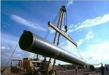
**Carga, acarreo y tendido.** La tubería será transportada por ferrocarril o por camión desde el lugar de fabricación, hasta los sitios de almacenamiento secundarios. Se utilizarán grúas para cargar la tubería a los camiones, que acarrearán la tubería al derecho de vía, donde será descargada con tractores pluma y será tendida en todo el largo sobre polines de madera.
