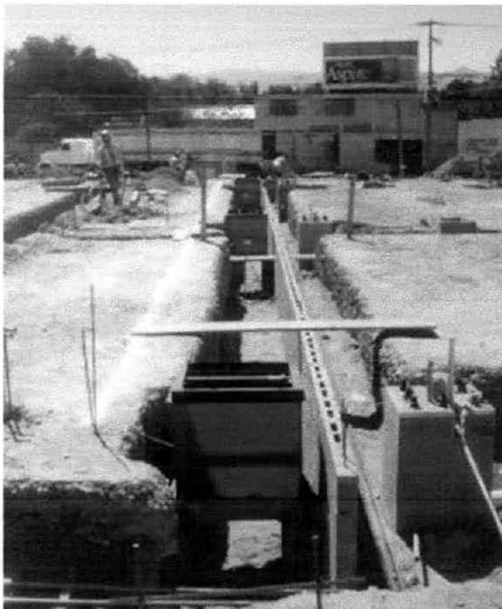
Colocación de contenedores para dispensarios de gasolina e instalación para dispensarios de agua y aire
