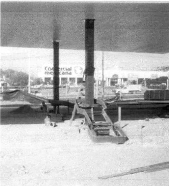
Colocación de las columnas de acero para la techumbre
