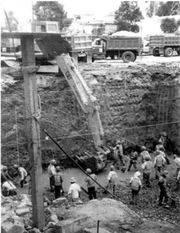
Excavación de la fosa para los tanques de almacenamiento de combustible, con retroexcavadora
