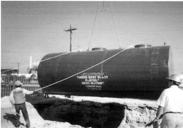
Revisión de los tanques antes de su colocación
