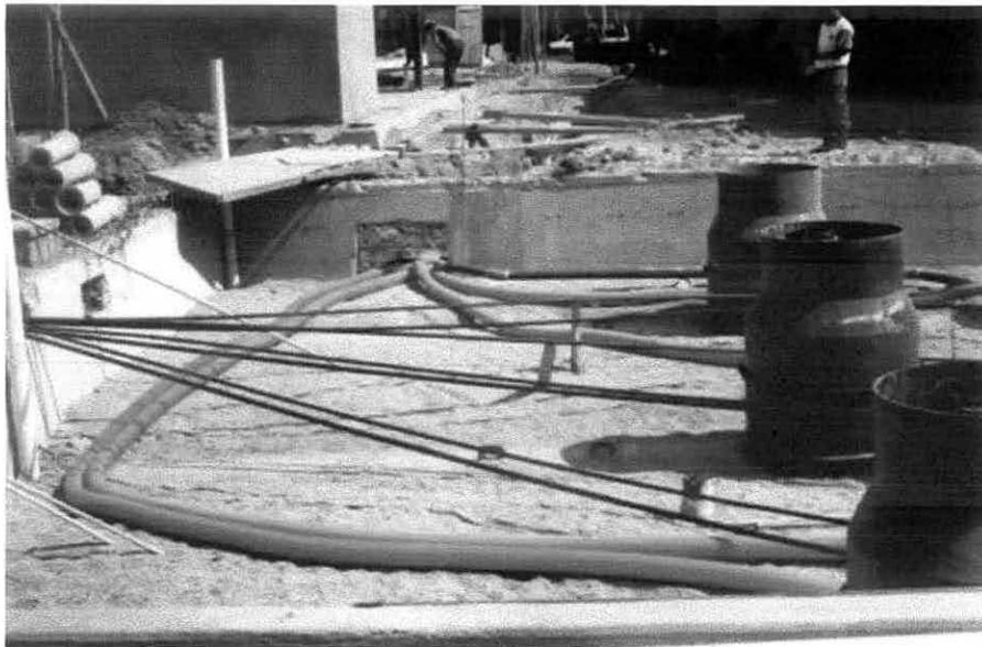
Conexión de las tuberías de producto a las motobombas de los tanques
