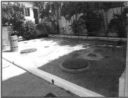
Foto 1.- Área de almacenamiento de combustible
