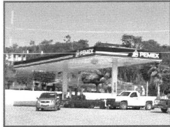
Foto 4.- Vista de instalaciones de la Estación de Servicios
