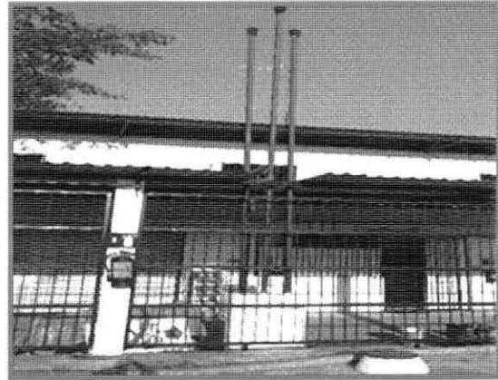
Foto 2.- Instalación de tubos de venteo y extintores de combustible
