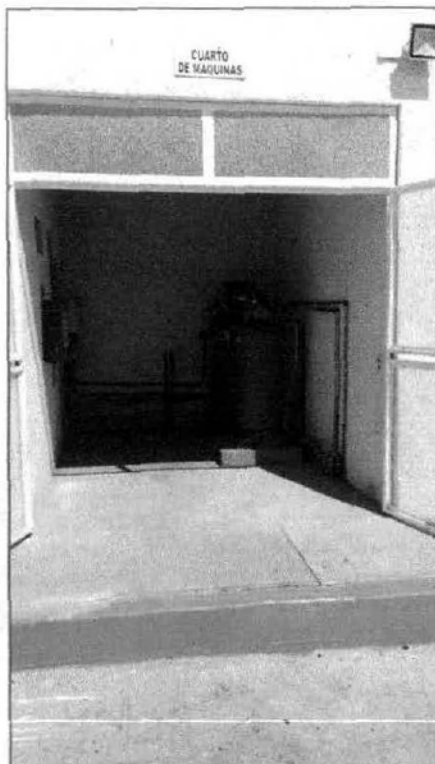
Fotografía No. 4 Cuarto de máquinas.
