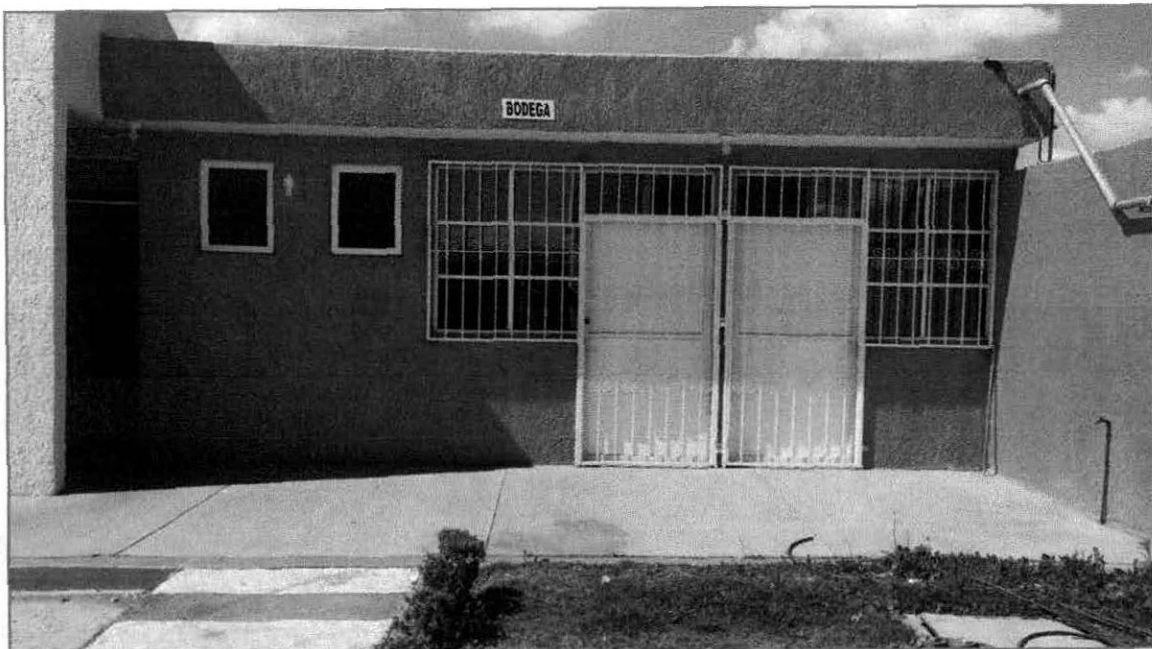
Fotografía No. 2 Espacio de confinamiento temporal de residuos/ cuarto de sucios y bodega
