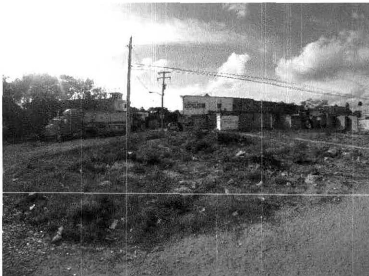
FOTOGRAFÍA 29. RED ELÉCTRICA CERCANAS AL SITIO DEL PROYECTO FUENTE: AP CONSULTORES 2017
