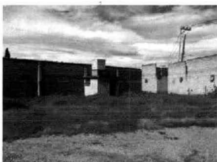
Fotografía 3. Interior del predio, vista poniente
