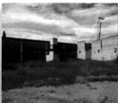
Foto 4: interior del predio vista oeste
