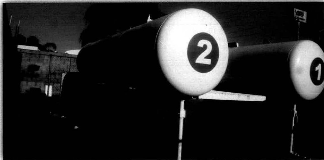
FIGURA 5. Tanques de almacenamiento de 5,000 L cada uno, ubicados en la Estación de Servicio (carburación) de Gas L.P. "Tres Ríos".
