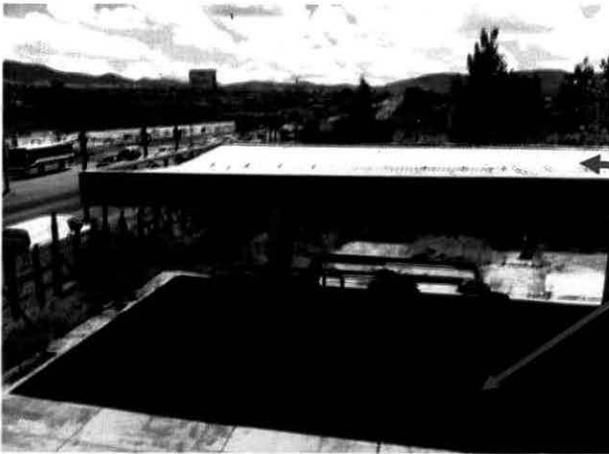
Techumbre de módulos de despacho, área de circulación de concreto hidráulico, barda de lámina donde es el acceso a la estación de servicio
