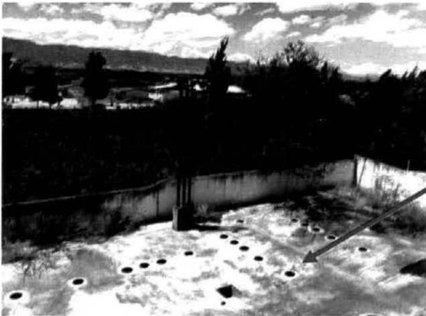
Área de tanques tapado con concreto, bardeado en dos lados con muro de 2.5 metros de altura
