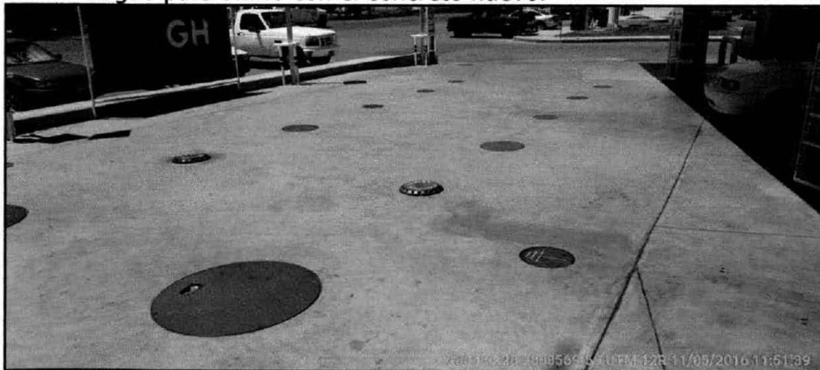
El pavimento de la estación de servicios se encuentra en óptimas condiciones. El color de las tapaderas señala el tipo de tanque o registro.
