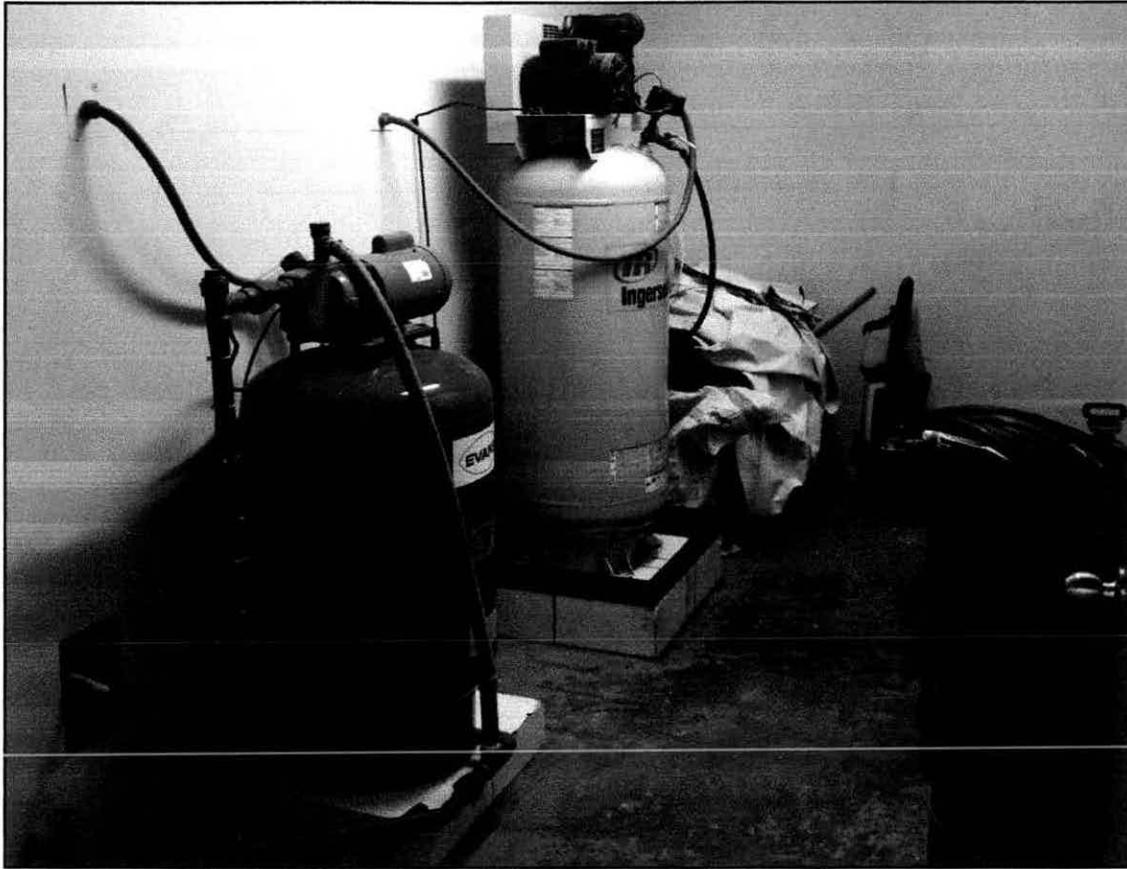
Cuarto de máquinas, compresor de aire, hidroneumático y al fondo se observa una maquina hidrolavadora que se utiliza para el lavado de los pisos de la estación.
