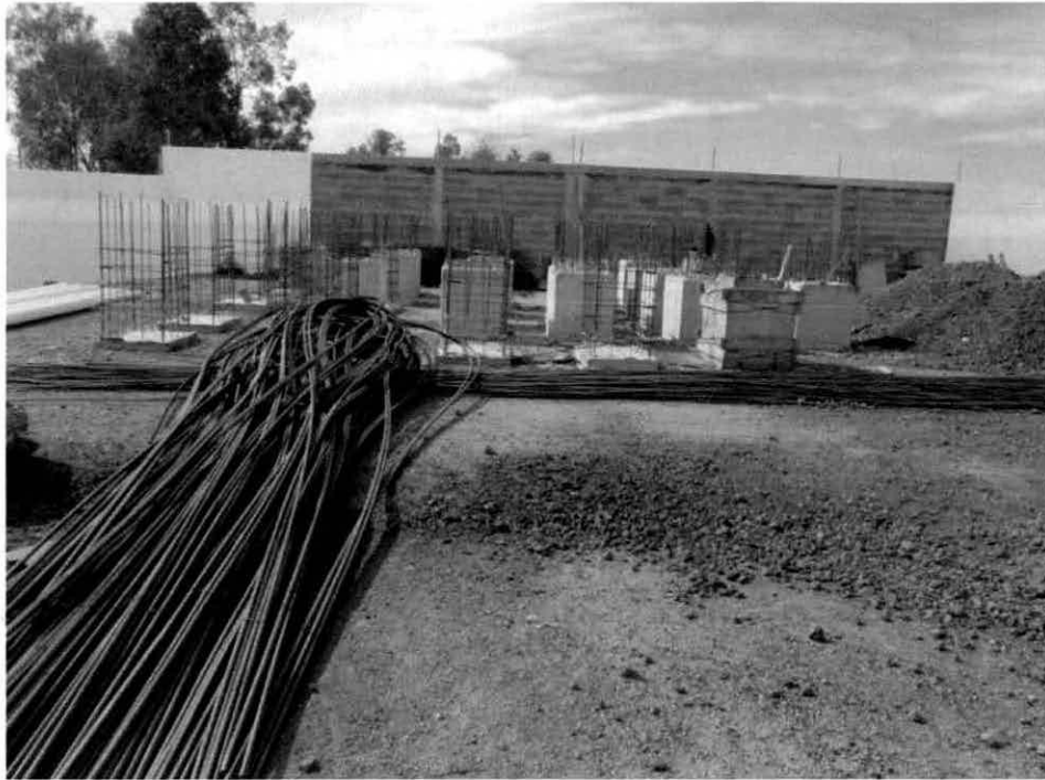
Materiales de construcción: varilla, pétreos y cajas para registros. Enero 2015
