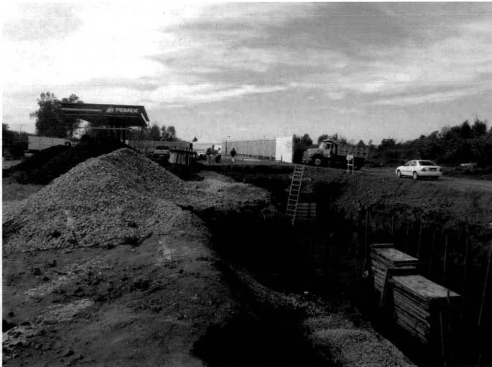
Vista General de la construcción. (Enero, 2015)
