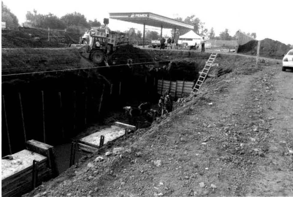
Excavación para instalar tanques de almacenamiento de combustibles. (Enero 2015)
