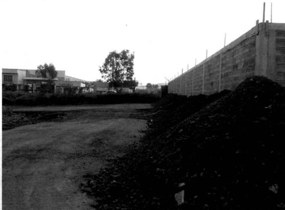
Barda perimetral de la parte norte del predio. Enero 2015
