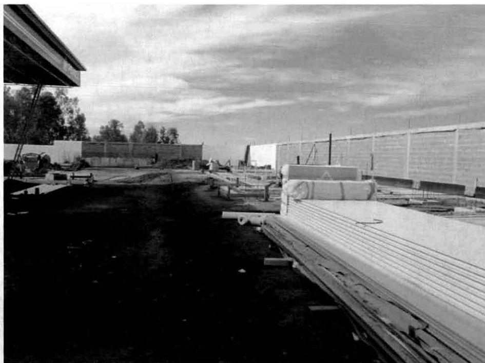
Materiales y bardas perimetral sur y poniente de la construcción. Enero 2015
