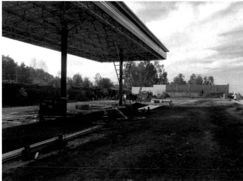
Techumbre, área de despacho de combustibles. Enero 2015
