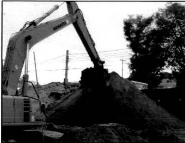
Imagen 53. Acumulación temporal de residuos producto de la excavación.
