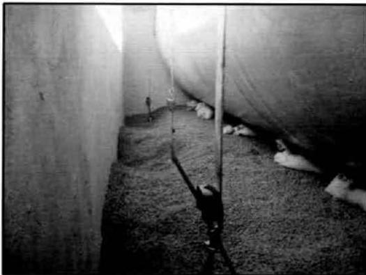
Imagen 10. Cinchado de tanque dentro de la fosa.
