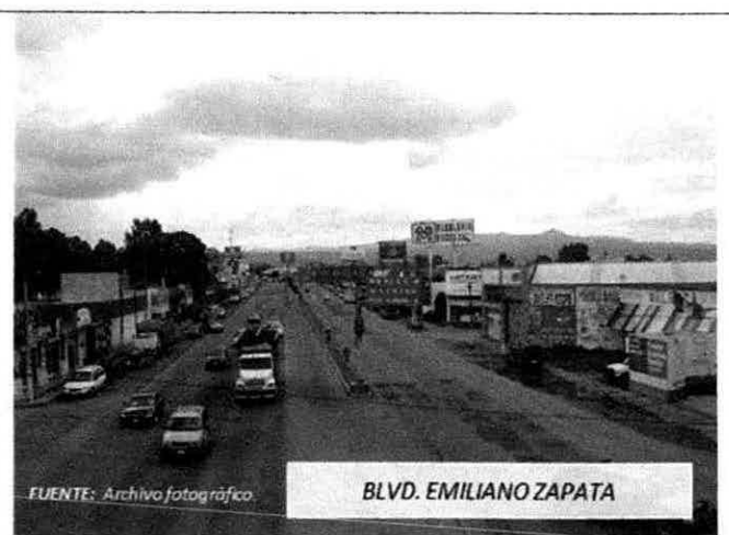
COLINDANCIA ESTE: BLVD. EMILIANO ZAPATA. VISTA NORESTE-SUROESTE. ZONA COMERCIAL Y SERVICIOS.
