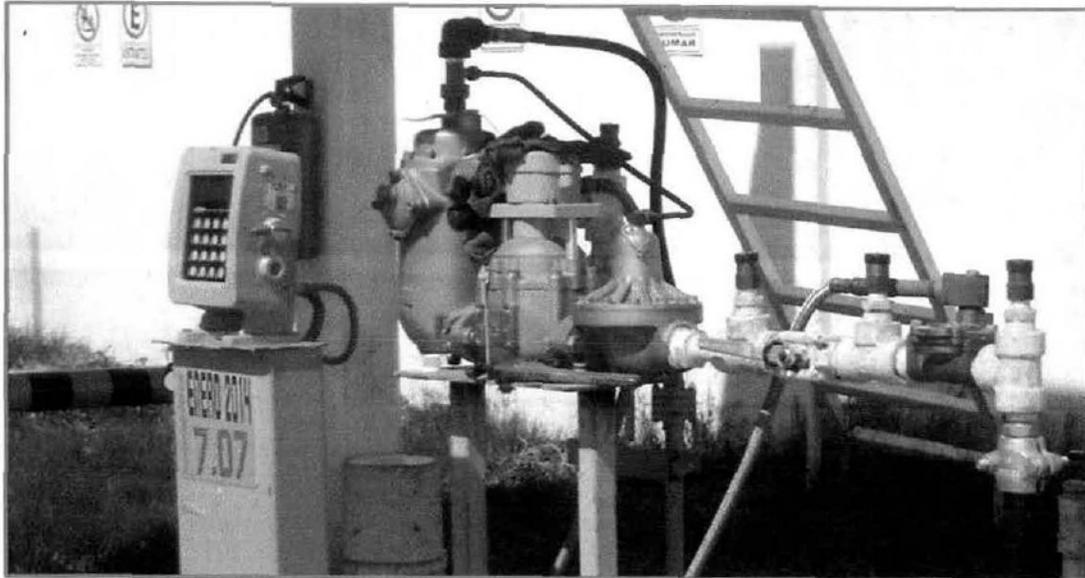
**Figura III.1.c)-1.** Dispensario doble para el Gas L.P.
