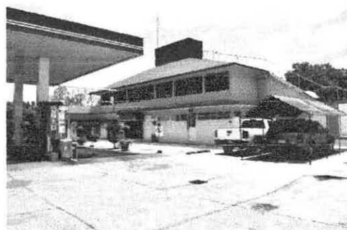
Fotografía 7. Área de edificio
