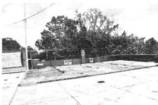
Fotografía 6. Área de tanques
