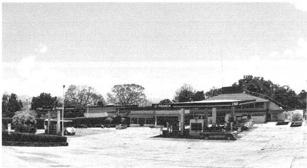
Fotografía 1. Acceso a la estación de servicio en operación
