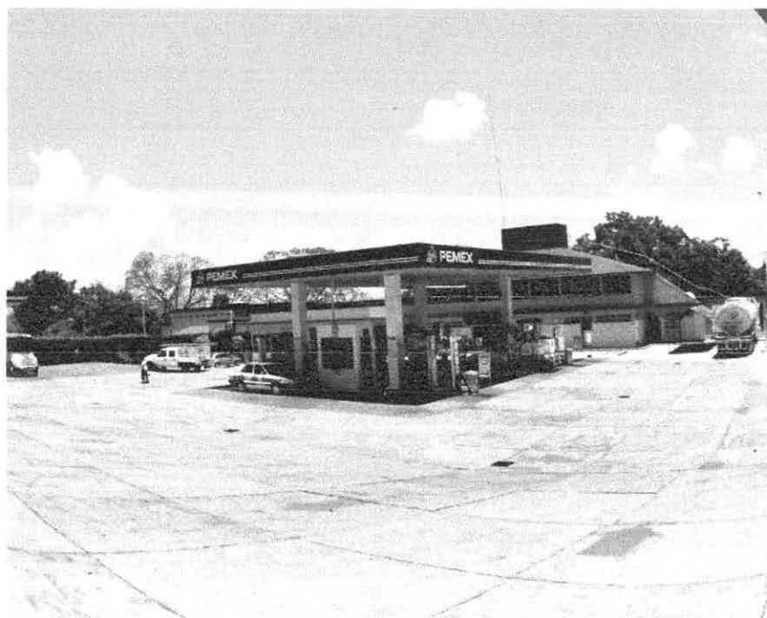
Fotografía 3. Vista estación de servicio en operación.
