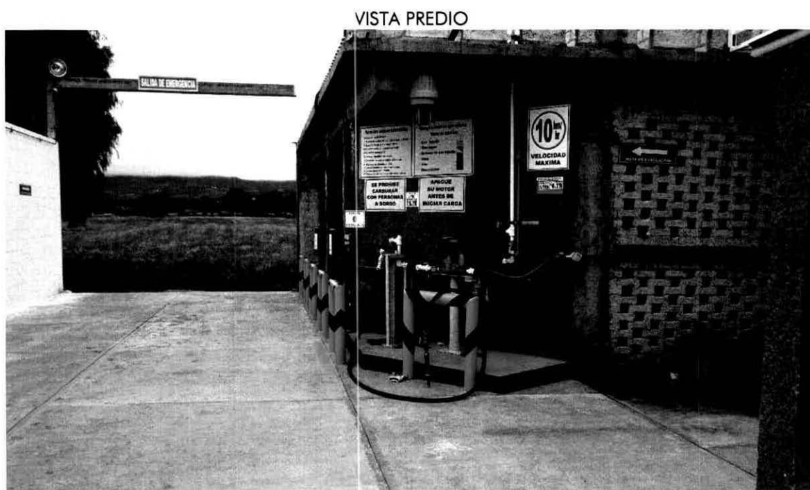
Se observa la toma de suministro.
