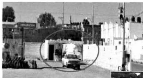
Oficinas y baños
