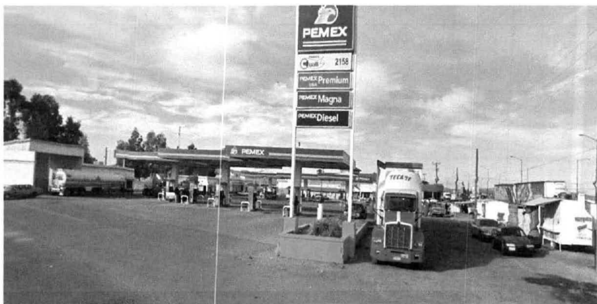
Imagen: Vista general de la Estación de Servicio E02158.
