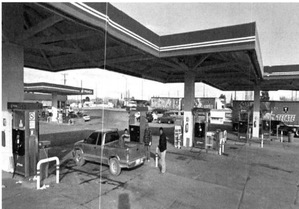
Imagen: Vista panorámica frontal de la Estación de Servicio E02158.
