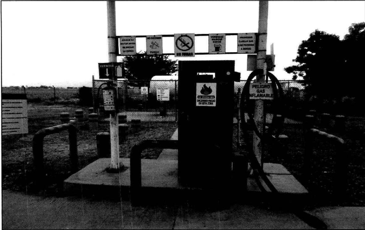
La toma está protegida por una válvula de exceso de flujo, y existe un punto de fractura entre la manguera y las instalaciones fijas, de tal manera que las válvulas permanezcan en su sitio y en posibilidad de funcionar. En el extremo de la manguera se tiene instalado una pistola de llenado tipo ACME, se cumple con las distancias mínimas requeridas y cuenta con cable caimán para aterrizar los vehículos. El diámetro nominal de las mangueras es de 25 mm y 7 m de longitud.
