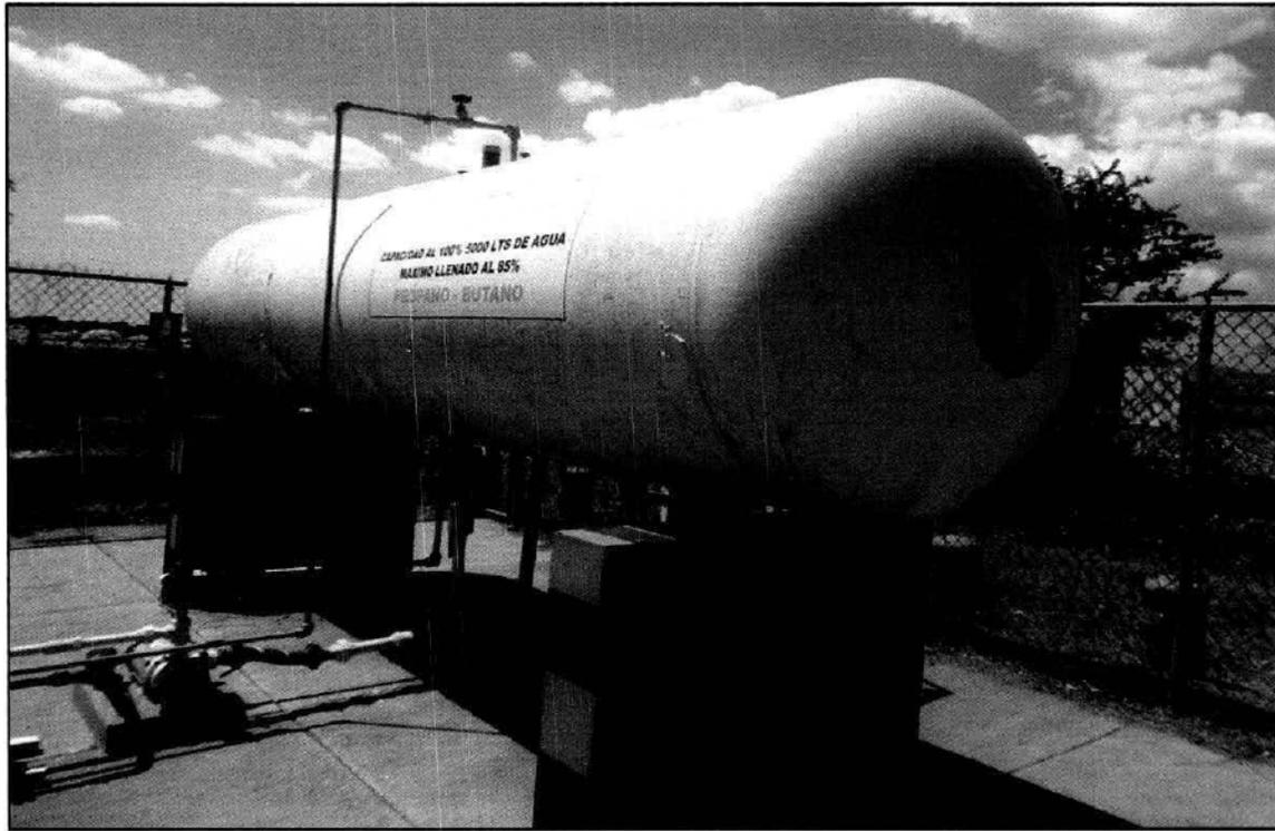
Cabe mencionar que la vida útil para los tanques de almacenamiento de gas L.P. se calcula en 10 años posterior a la fecha de fabricación. Culminando ese plazo se les realizarán pruebas de ultrasonido cada 5 años para conocer su estado físico y puedan prolongar su utilización para continuar ofreciendo el servicio seguro de almacenamiento autorizado por la SENER, de acuerdo a lo establecido en la NOM-003-SEDG-2004.
