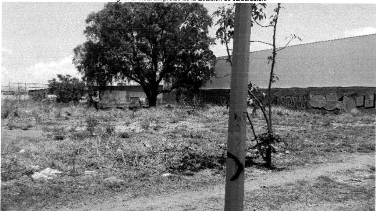
Figura 3. Vista de las instalaciones existentes de la Estación de carburación.
