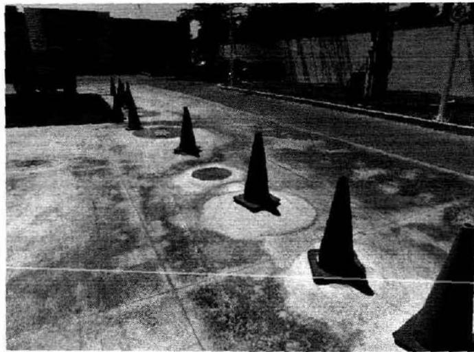
Vista de la zona donde se realizará la ampliación de la zona de despacho se observa piso de concreto armado que corresponde a los tanques de almacenamiento, pavimento asfáltico de la circulación interior, áreas verdes con pastos y los tubos de venteo.
