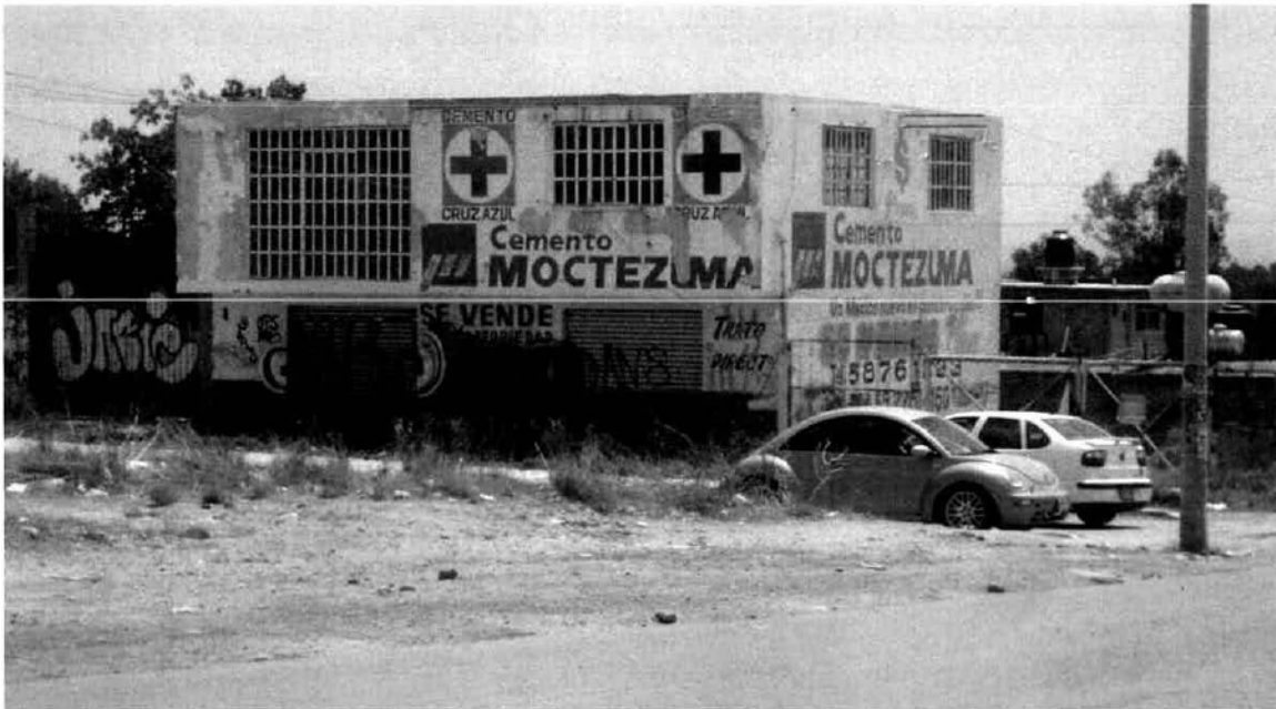
Estructura ha eliminar
