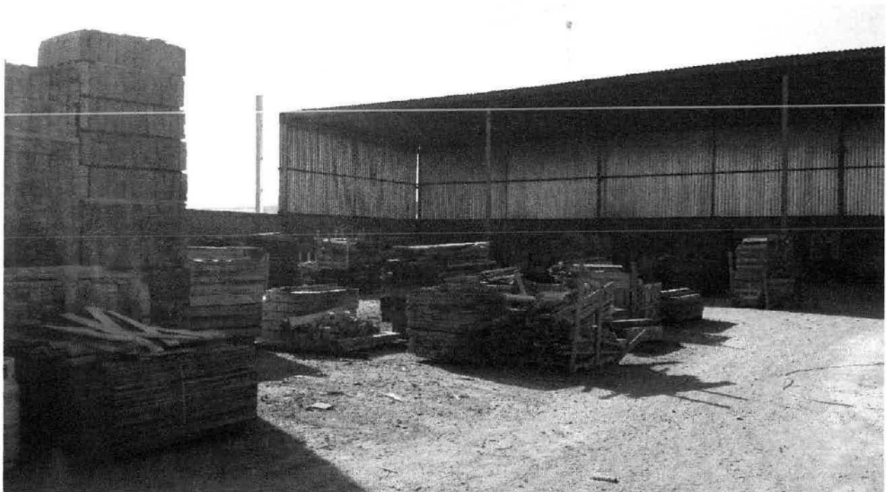
Foto. 4 Techumbre y almacenaje de madera para la elaboración de tarimas de carga.
