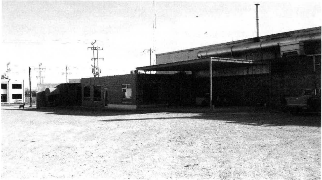
Foto. 3 Oficinas y techumbre dentro del predio.
