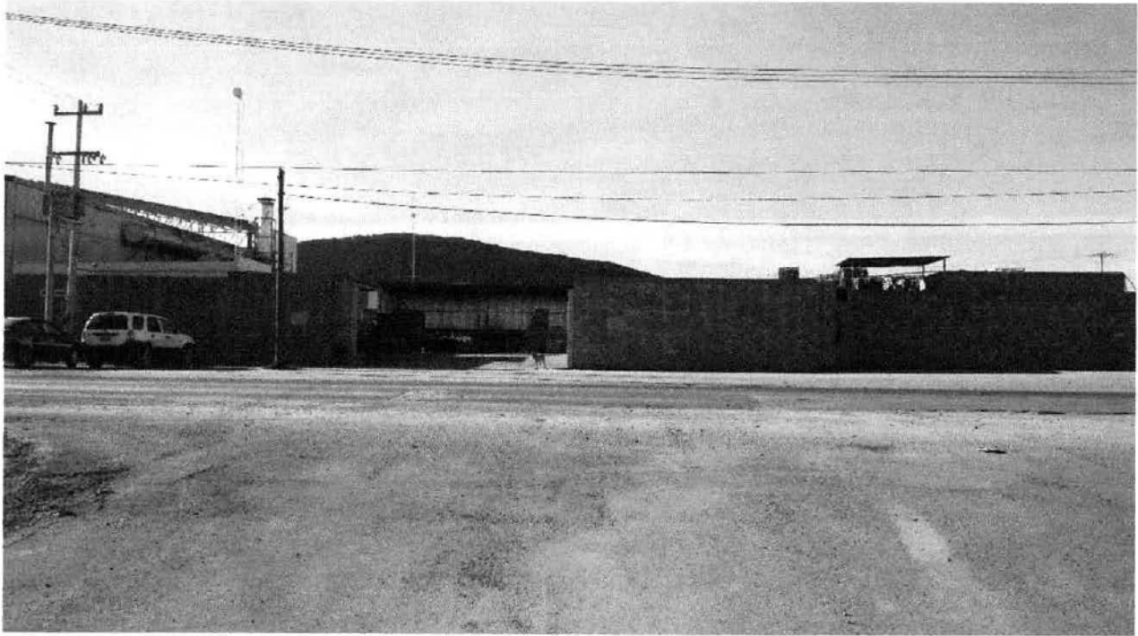
Foto 1 Vista frontal del predio, al fondo las tarimas para carga y se encuentra delimitado por bardas de block de concreto.
