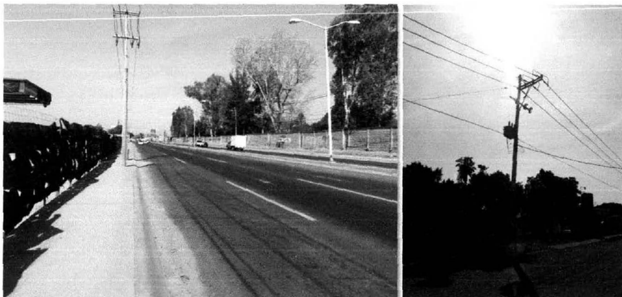
Figura 17. Línea eléctrica y alumbrado público en Prolongación Colón (izquierda) y por Callejón sin nombre (derecha), en las colindancias con el proyecto.
