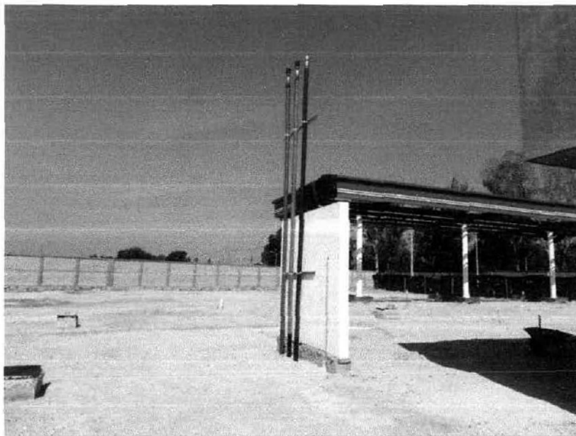
Figura 15. Imagen de los tubos de venteo instalados en la E.S.
