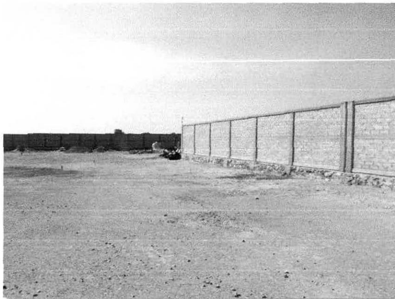
Figura 14. Imagen del muro perimetral.
