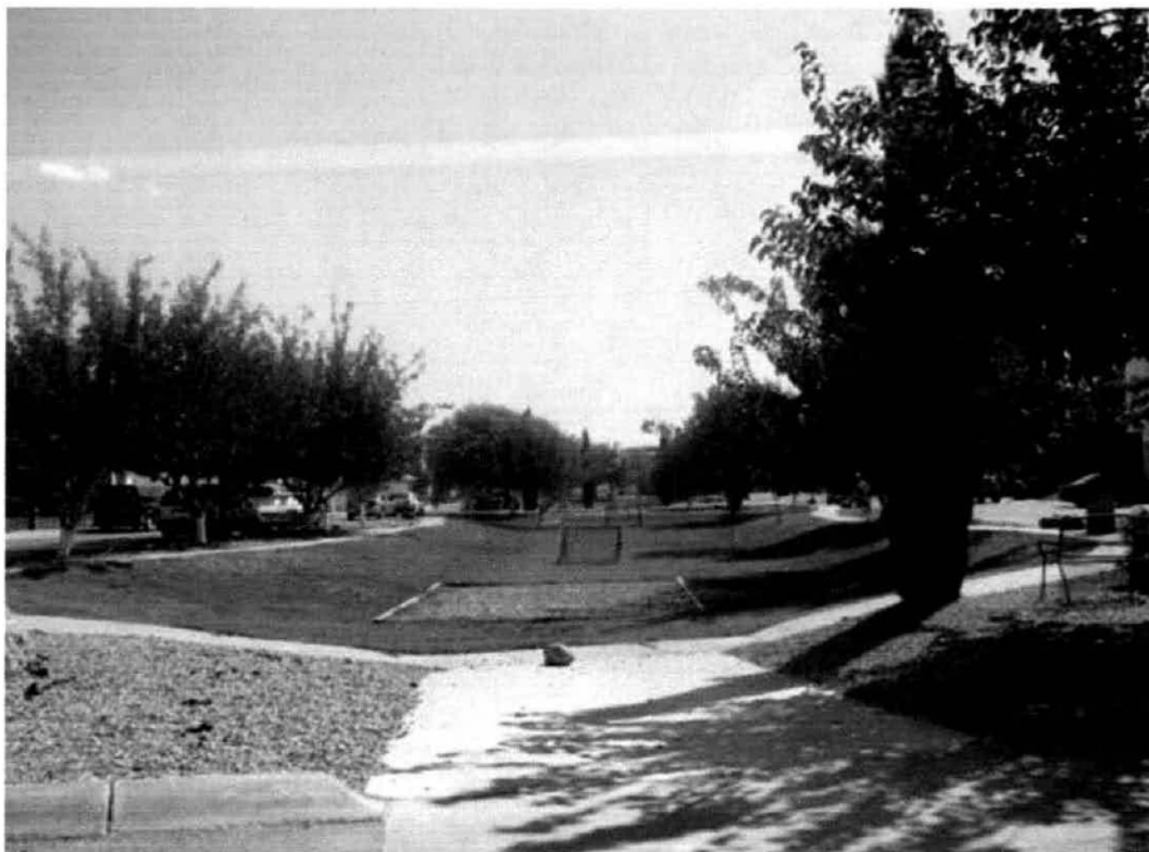
Figura III.13.- Parque con sistema de absorción Fuente: Archivo fotográfico IMIP, 2007
