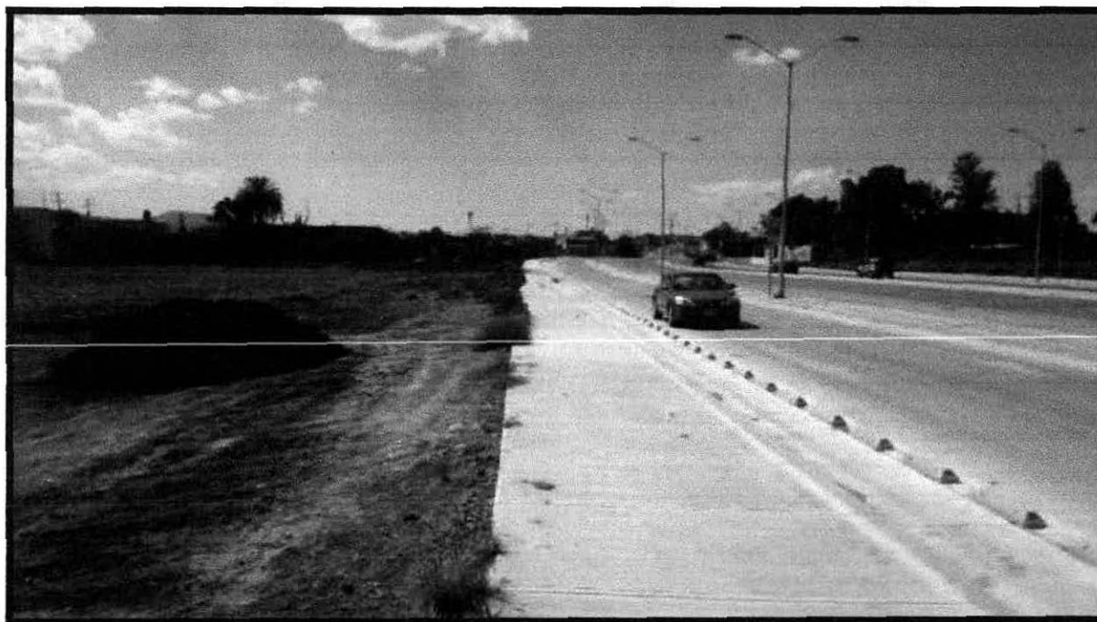
Ilustración 19 Eje Vial Herminio Martínez, vista de Este a Oeste sobre las inmediaciones del sitio del proyecto
