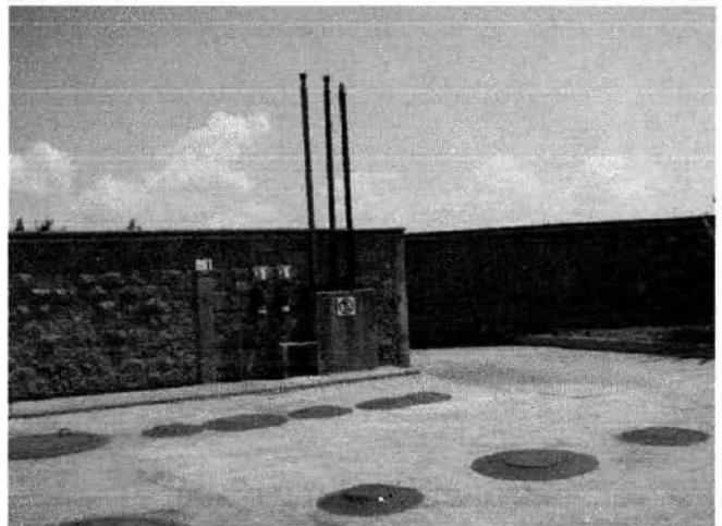
Área de confinamiento de tanques de almacenamiento de combustibles de doble pared sobre fosa de concreto armado
