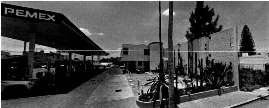
Imagen lateral de la Estación de Servicio por la calle Alvino García.
