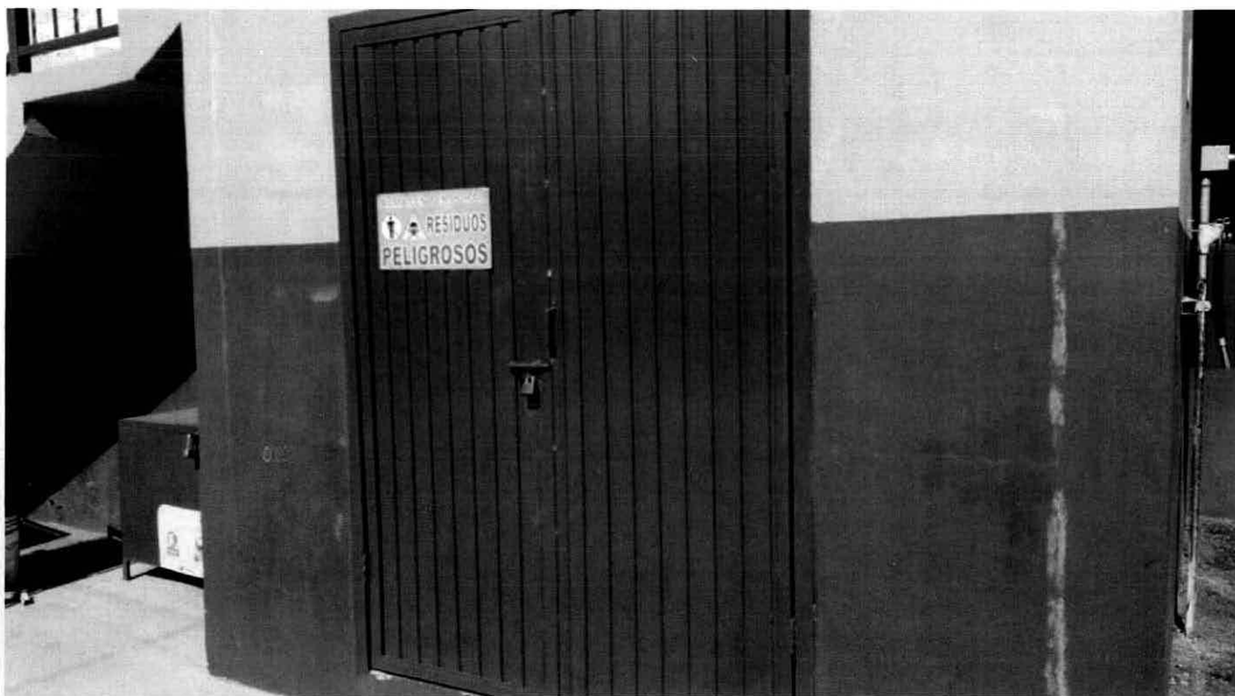
Fotografía 6. Almacén temporal de Residuos Peligrosos.
