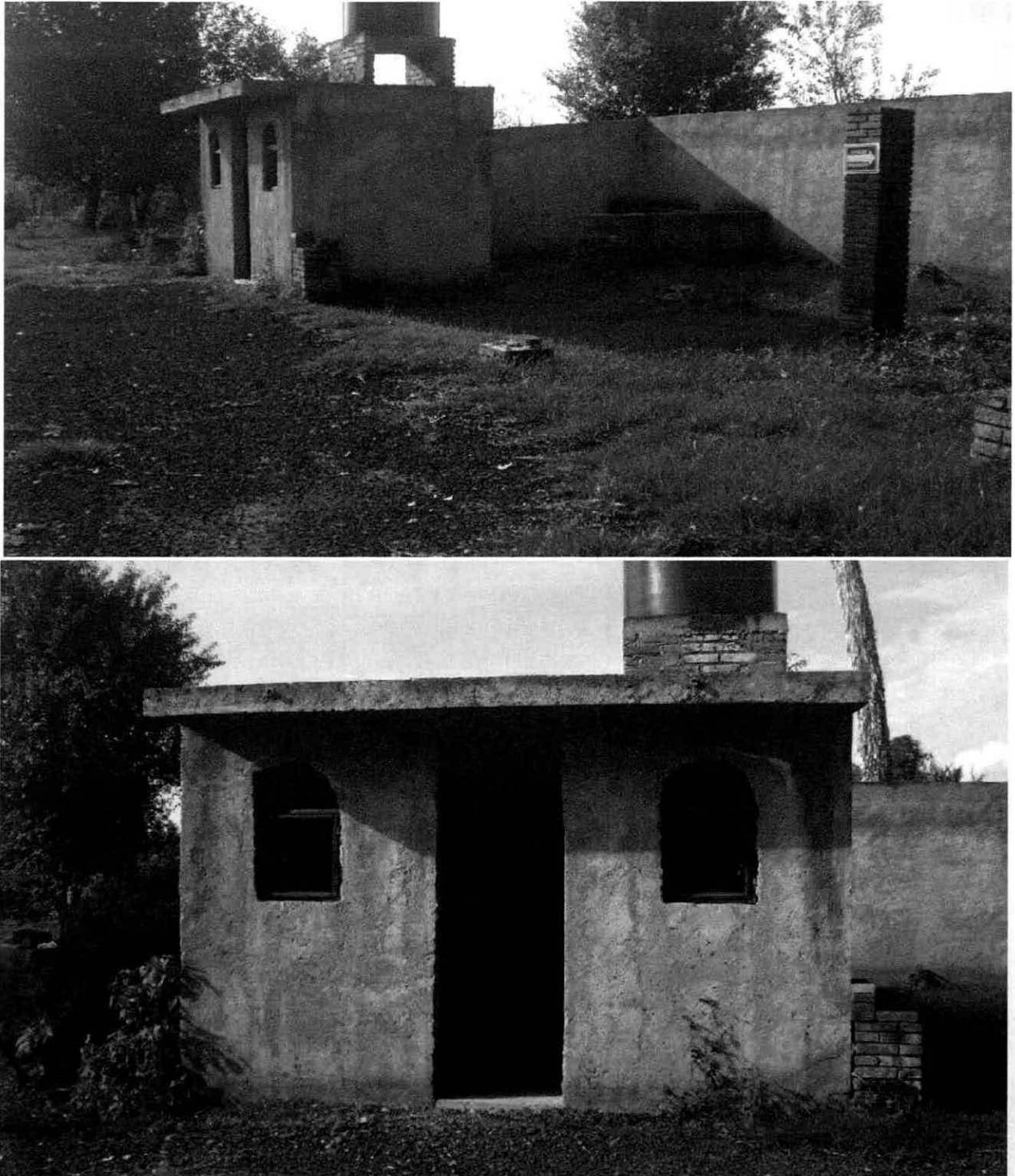
Figura 8. Fotos de las obras actuales que se encuentran en el predio que serán acondicionados y aprovechados para el proyecto.
