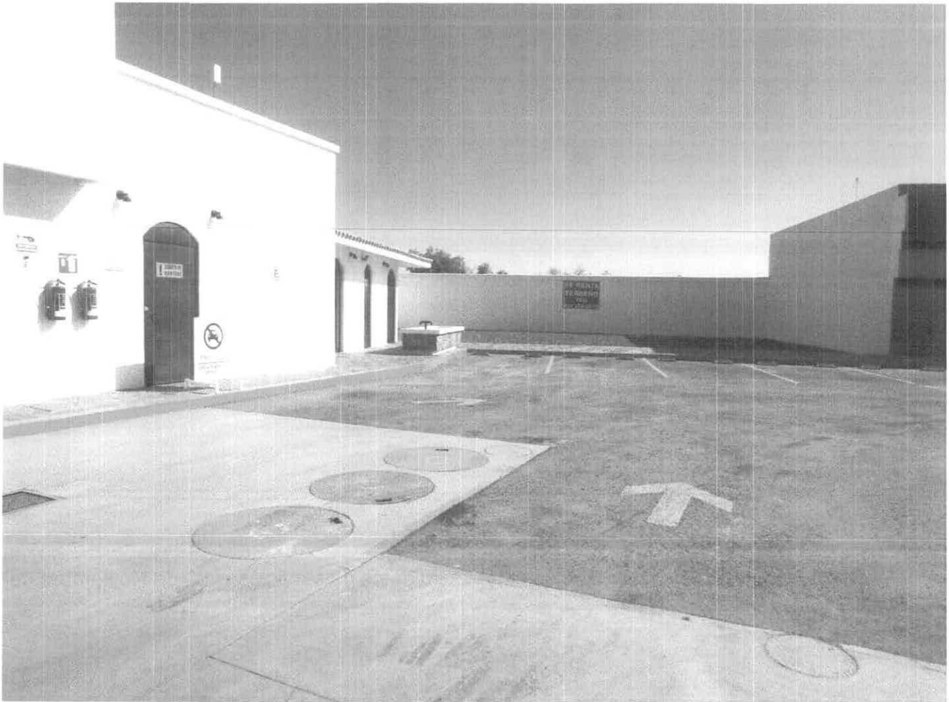
Predio delimitado con bardas para evitar el deterioro de las áreas colindantes.
