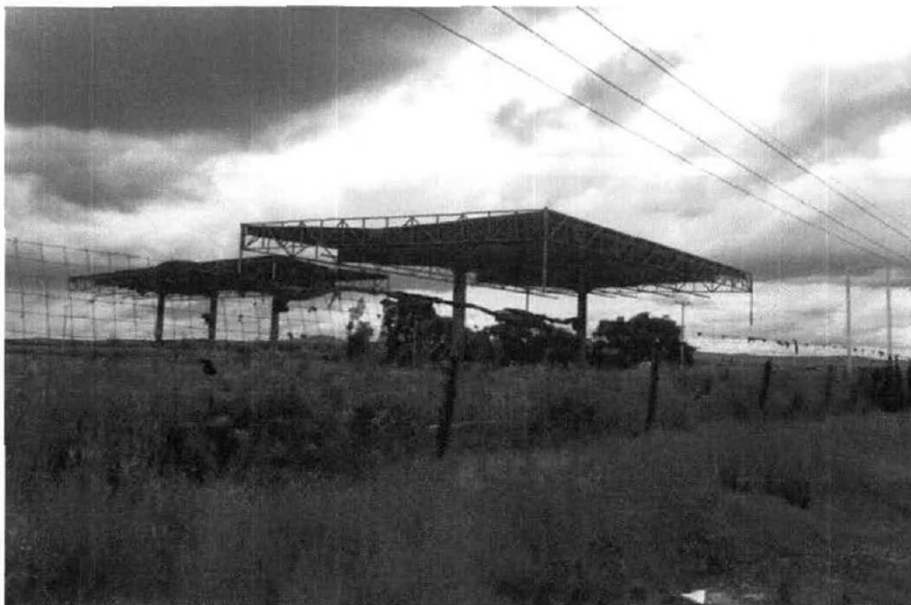
Se tiene instalada la techumbre de los dispensarios.
