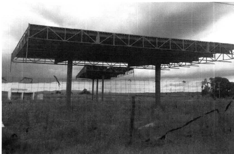
Aunque ya se habían realizado los trabajos de preparación del sitio, que consistió en nivelación y compactación, ya se tiene crecimiento de maleza.
