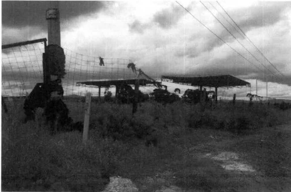
Fotos de la estación de servicio Arco Norte II
