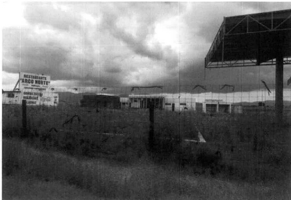
El predio se tiene delimitado y suspendidos los trabajos de construcción.
