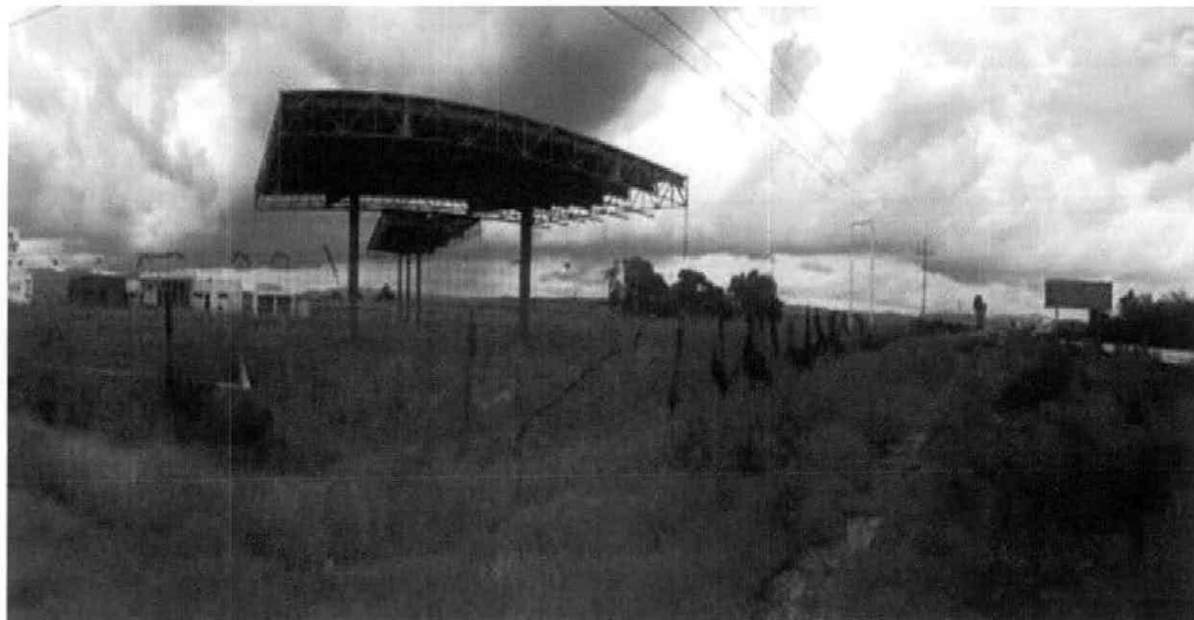
Se suspendieron los trabajos de construcción y se tiene el crecimiento de maleza en el predio.
