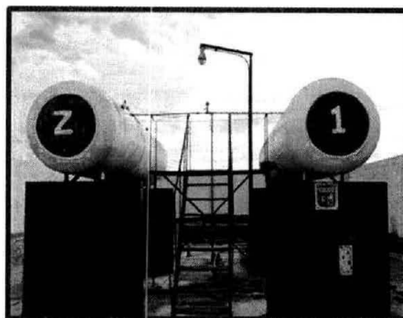
Imagen 7. Tanques de almacenamiento.
