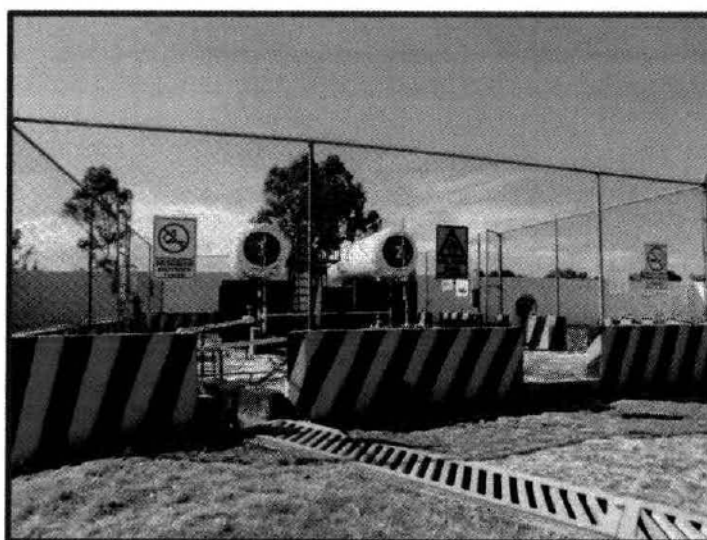
Imagen 5. Tanques de almacenamiento.
