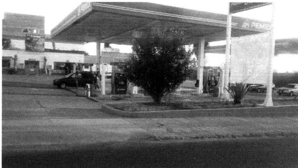
En esta imagen se muestra la estación de servicios área verde, módulo de despacho de gasolina y al fondo edificio de oficinas
