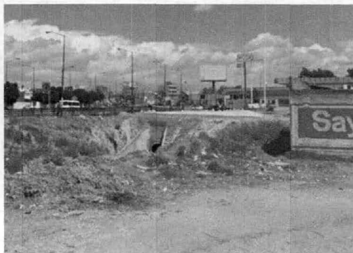
Fotografía III.1. Vista de las obras de entubamiento del cauce de la Barranca Xalpatla
