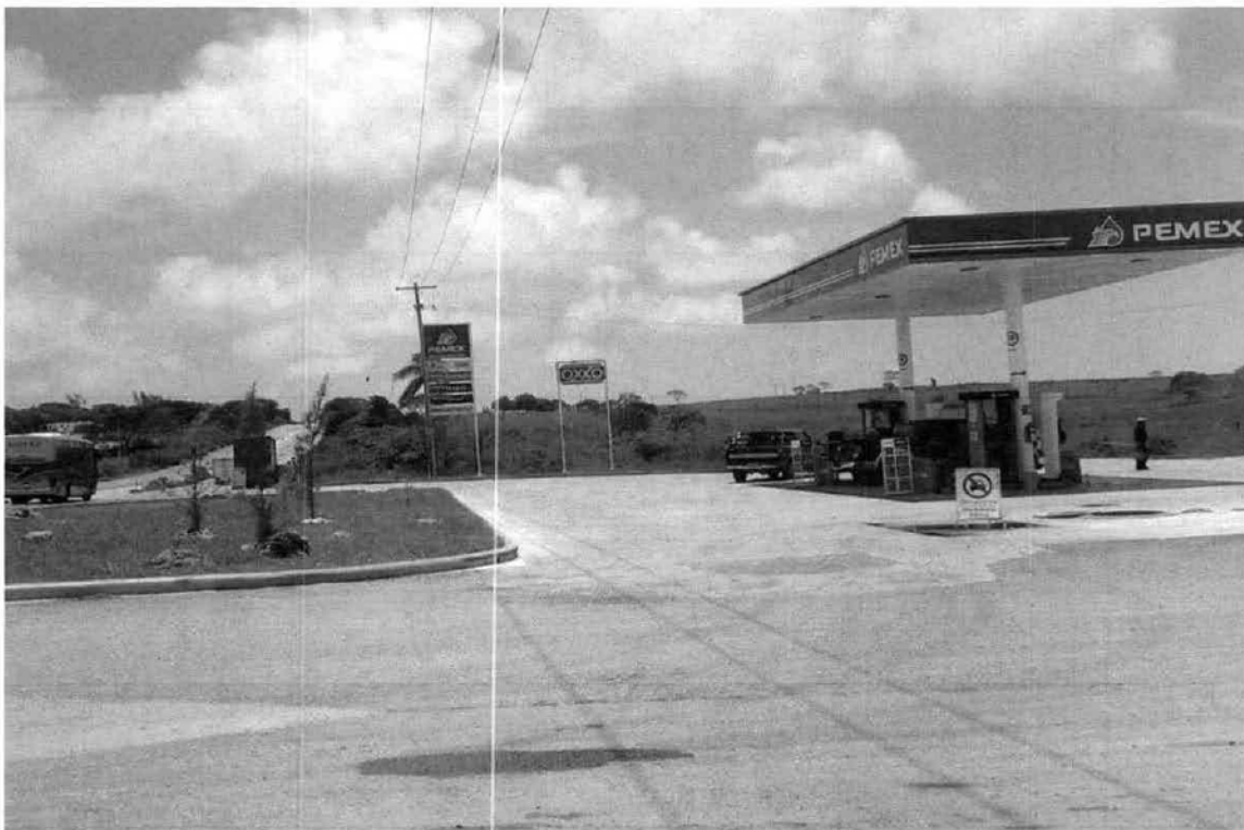
Imagen: Vista panorámica frontal de la Estación de Servicio E12341.
