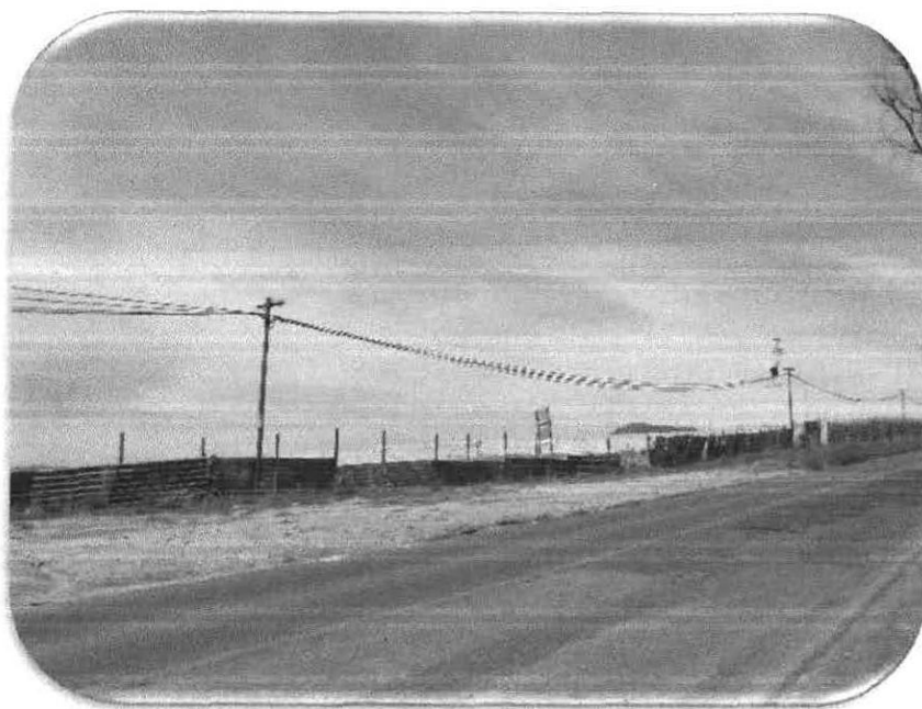
Fotografía No. 5. Vista de la estación de servicio “ SÚPER SERVICIO SUMOFA S.A. DE C.V. ” donde se observan algunos avances respecto a la limpieza y nivelación del terreno, así como la construcción de la barda perimetral.
