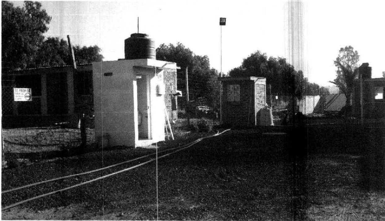
**Foto 1** Baño y caseta de vigilancia en la Estación de carburación, el piso se cubrió con cascajo rojo para evitar la dispersión de polvos y permitir la filtración del agua a las capas inferiores.
