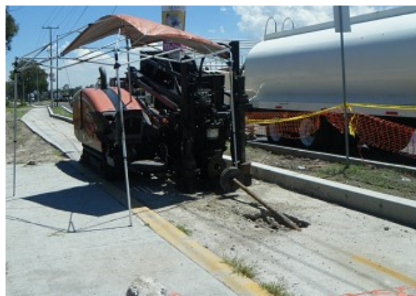
Imagen ilustrativa: perforadora direccional de las utilizadas por la empresa para los cruces subterráneos.
