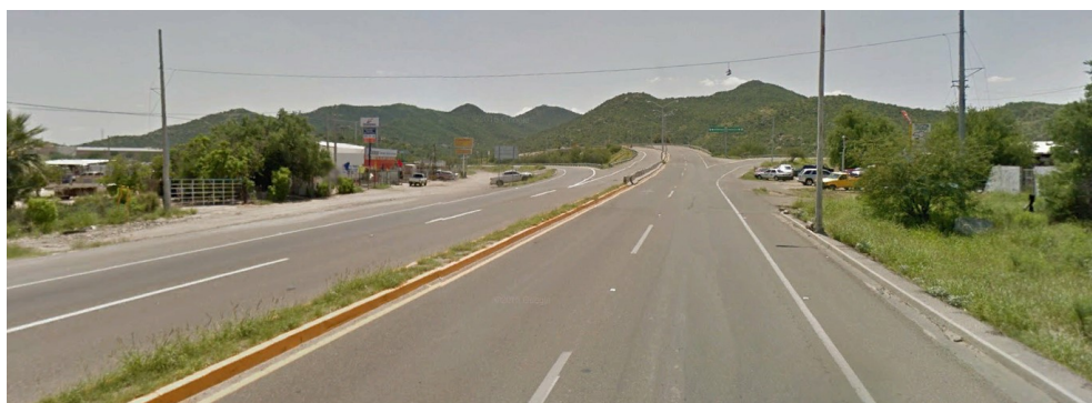
Foto 8. Ingreso a la Cd. de Hermosillo desde el Noreste por la carretera federal 14.
