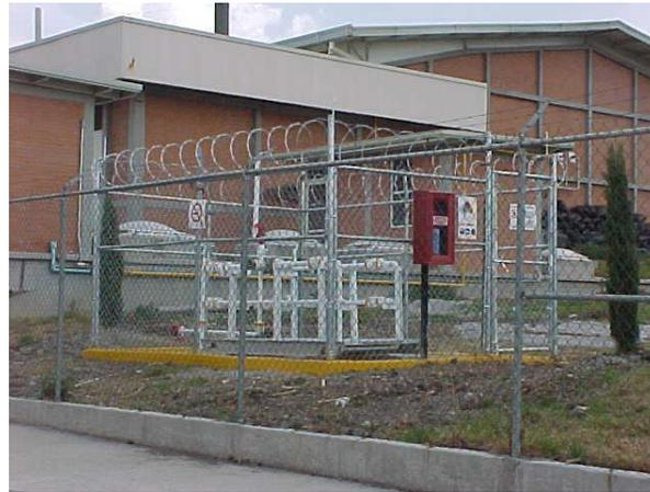
Figura 8 Extintor tipo ABC en caseta de medición y regulación (Predio del Usuario y del Parque)
