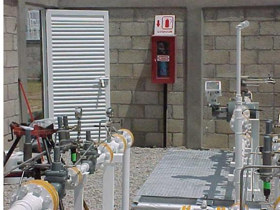
Figura 7 Extintor tipo ABC en caseta de medición y regulación (Interconexión)
