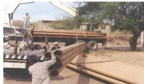
Figura 12 Transporte y manejo del tubo
