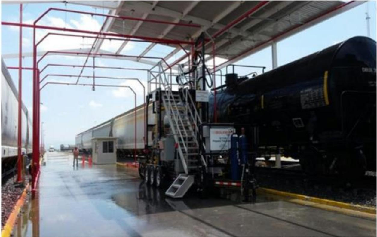
Fig. 10. Transloader para combustible gas L.P.
