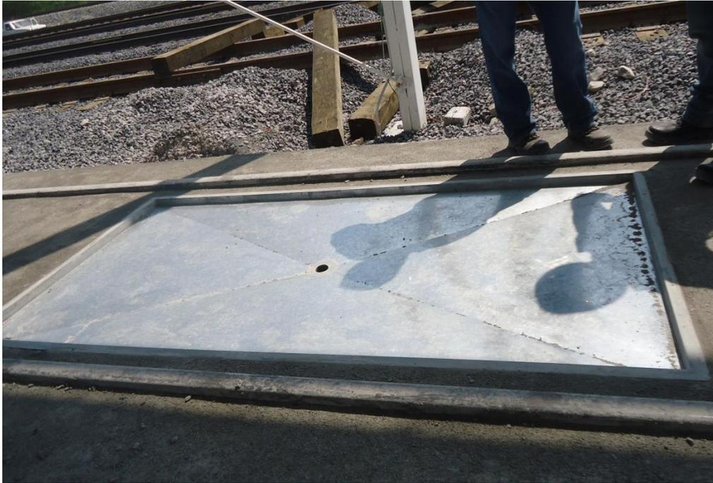
Fig. # 17. Charolas para canalización de derrames hacia fosa de contención.
