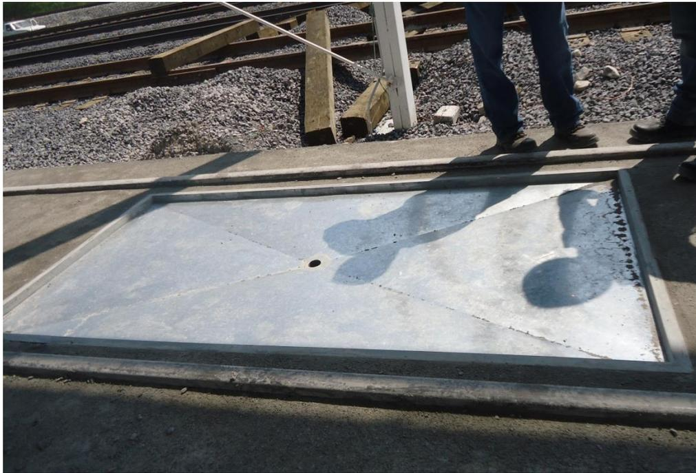
Fig. # 5 Charola fija para derrames en estación de trasvase de diésel.
