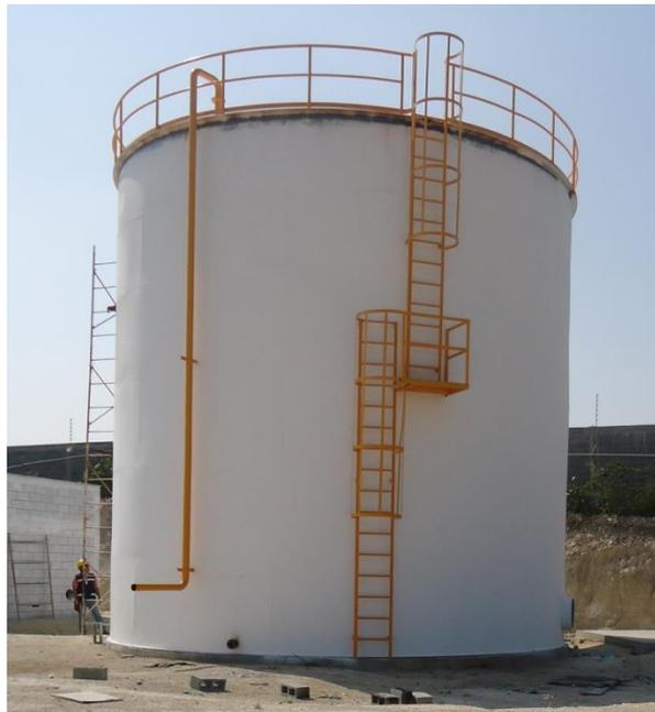
Fig. # 8. Tanque de almacenamiento de agua contra incendio
