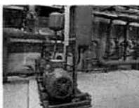
Bomba JOCKEY. Operación con motor eléctrico, tipo centrifuga, marca WDM, modelo VSE-3-8-15 con succión y descarga de 50 mm y capacidad de 0.33 lpm contra una carga de 70m, motor eléctrico de 1 ½ Hp.
